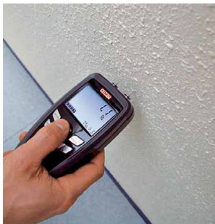
Měření vlhkosti betonu
