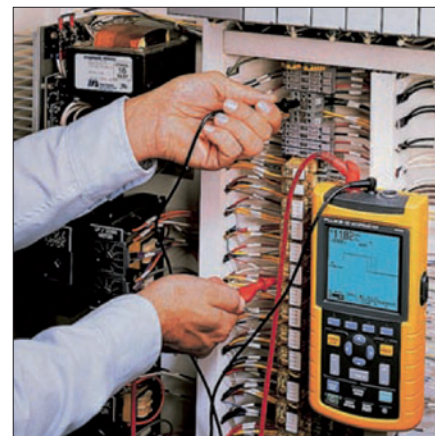
Obr. 2. Ověření případného svodu či přerušování
